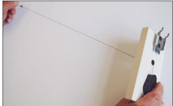
Stahlseil durch die Hülse führen und bis zum Anschlag durchziehen.
